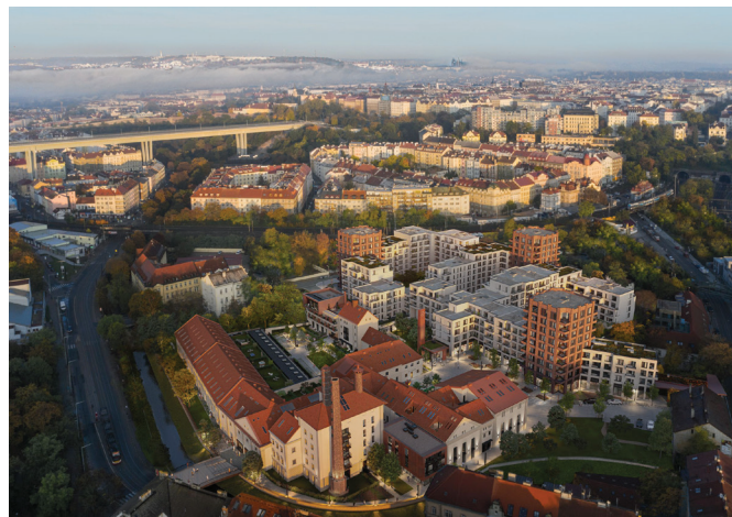
Obrázek 12 Ptačí pohled na revitalizovaný areál Nuselského pivovaru směrem na severozápad, zdroj: Penta Real Estate, 2023
